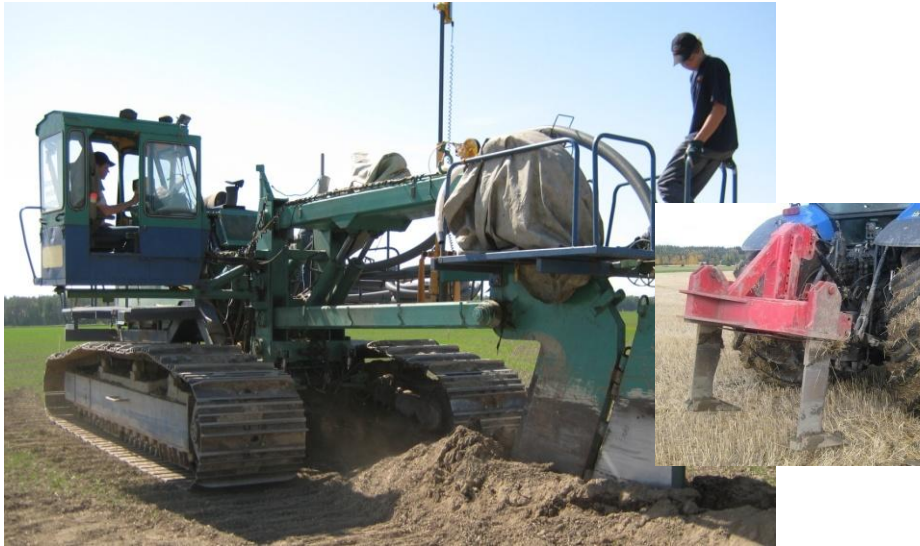
A tavanomaista tiheämpi uusintaajitus 2008 (ensiojitus 1952); ojaväli 6 m + ympärysaineena ohut suodatinkangas, aurasalaojakone, jankkurointi 2009
