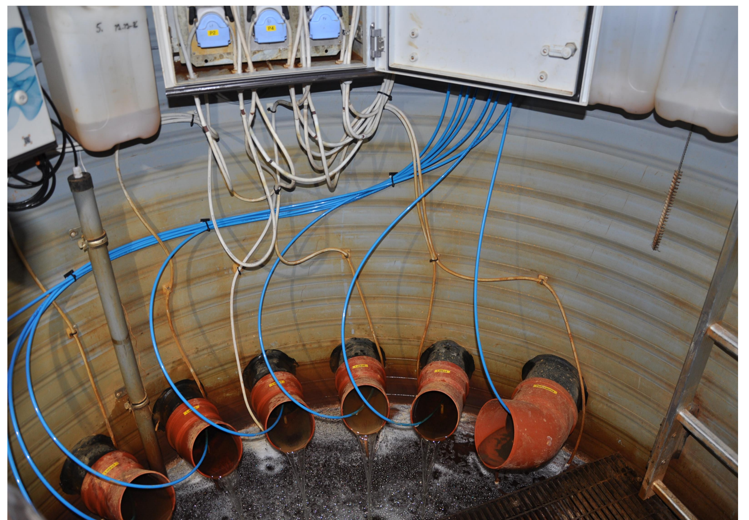
Kuva 2. Jokaisen peltolohkon salaojavedet johdetaan mittauskaivoon. Näytteenotto tapahtuu kuvan yläreunan letkupumpuilla, kun tietty vesimäärä on virrannut ojaston läpi. Laitteiston on toimittanut EHP Environment Oy.
