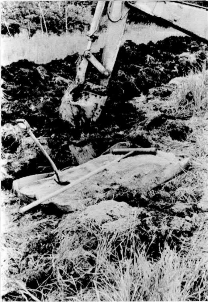
Kuva 6. Sorakuoppa ja pohjajuntta.
