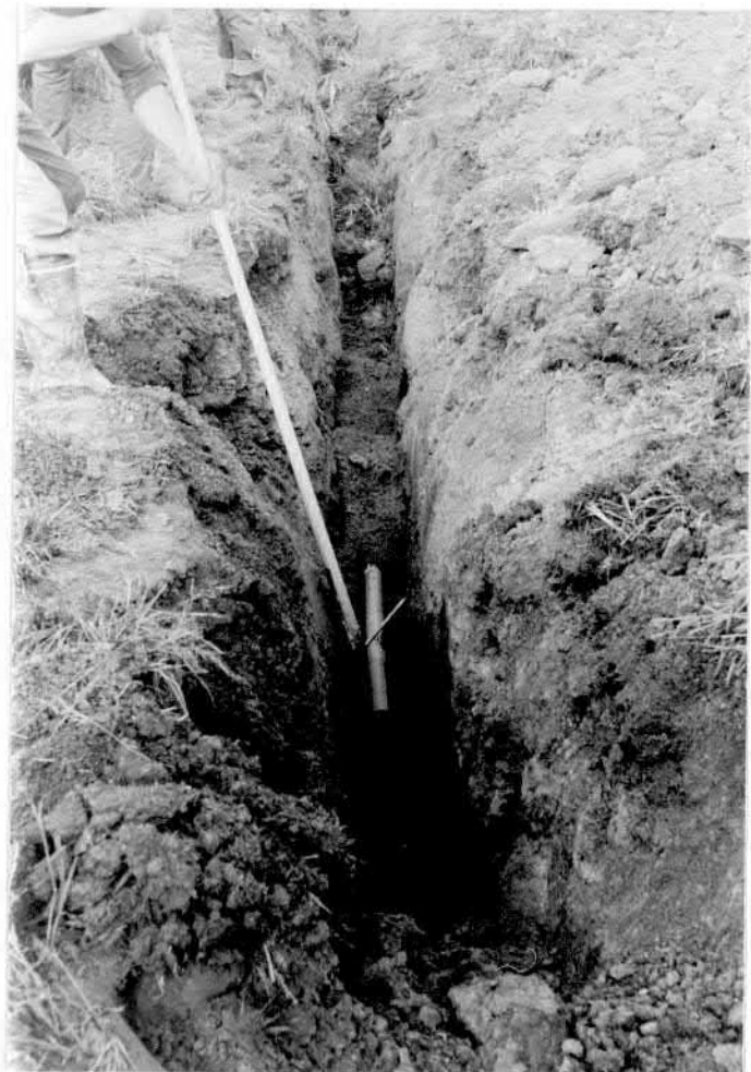
Kuva 3. Tiiliputken asettaminen ojaan.
