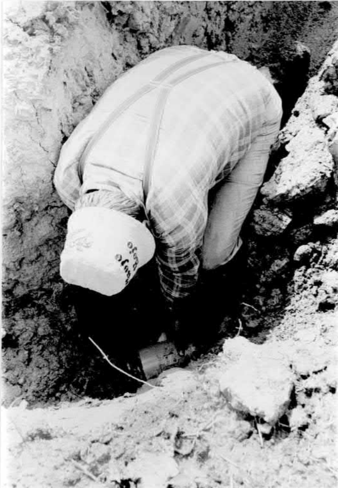
Kuva 4. Muoviputkiliitoksen tekeminen.
