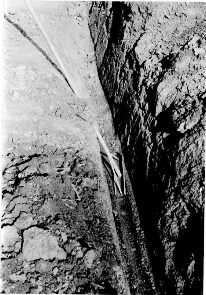
Kuva 7. Pohjajuntta sekä tasattua ja tiivistettyä ojanpohjaa.
