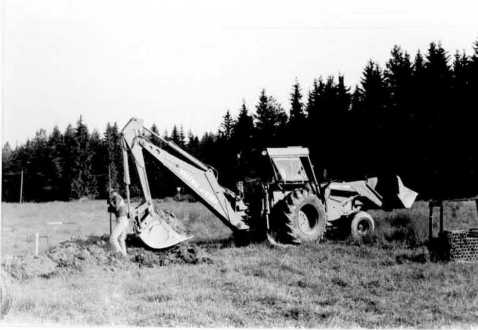
Kuva 1. Kuokkakaivulaitteella varustettu traktorikaivuri.
