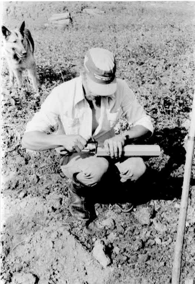
Kuva 8. Tiiliputken pään muotoilu.
