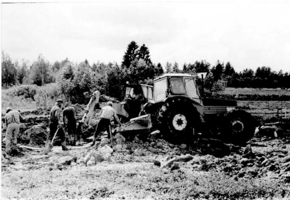
Kuva 13. Näkymä Verstan salaojitustyömaalta.
