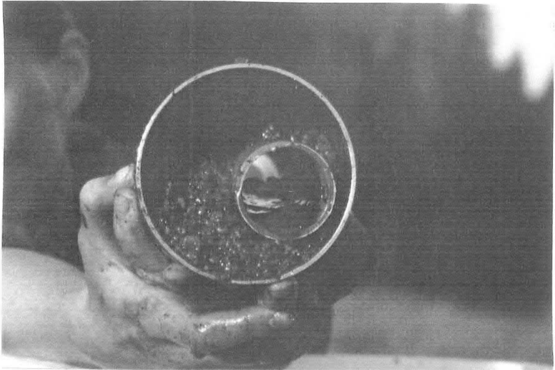
Kuva 41. Imuojista löytyi noin 1 cm paksu sakkakerros.
