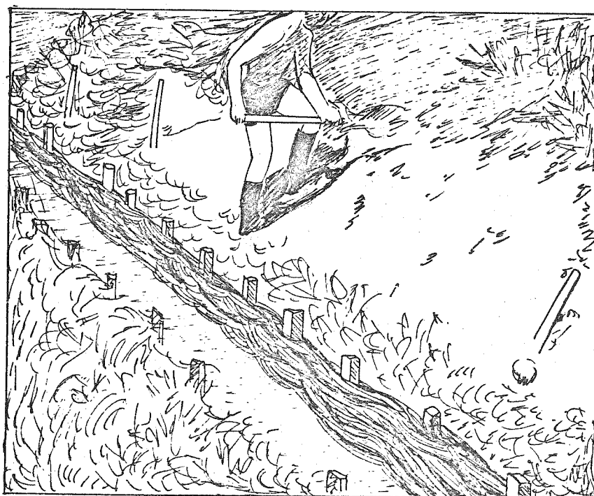
Kuva 94. Risupunoksella vah- vistettua ojaa
