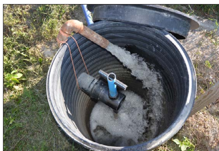
Kuva 1. Säätökaivon avulla säädetään pohjaveden pinnan tasoa. Kaivon kautta ojastoon voidaan pumpata lisävetä. (Kuva: Rainer Rosendahl.)
