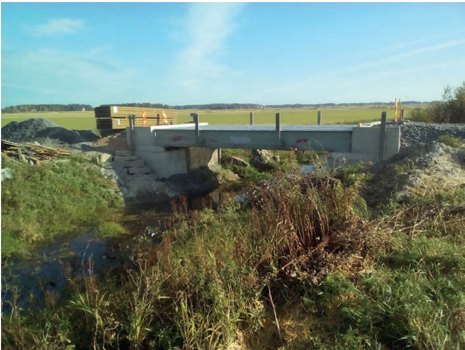
Siltätyömaa Luopajärven tilusjärjestelyalueella Jalasjärvellä.
