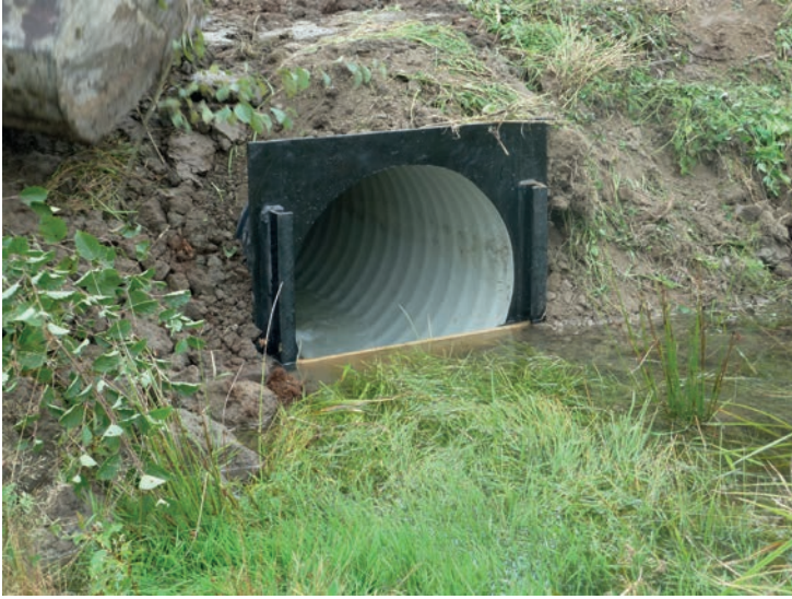
Kuva 1. Rumpuun vedenkorkeuden säätöä varten asennettu säätömoduuli (Jita Oy).
