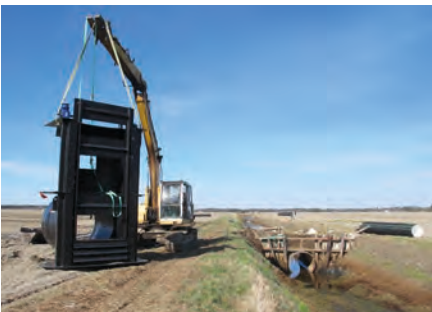
Padon asennus vuonna 2018.
