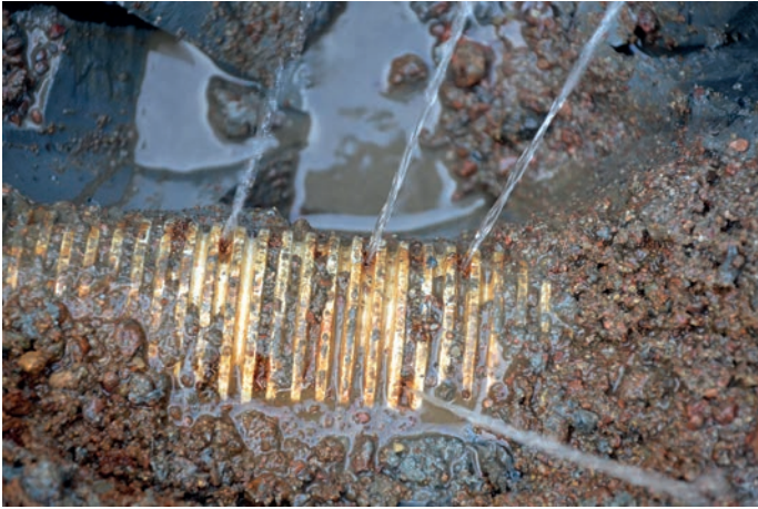
Kuva 4. Salaojan ympärysaineeseen on saostunut ruostesakkaa, ja saostuma on tukkinut putken reikiä. Kuvassa salaojaputki huuhdellaan.
