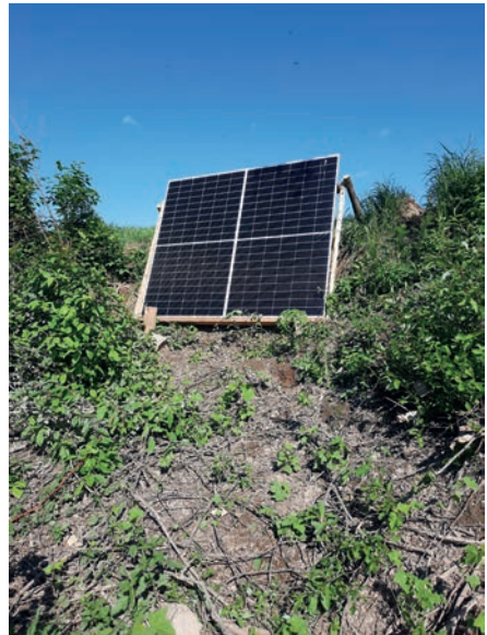
Kuva 6. Aurinkopaneelitoiminen pumppu asennettiin joessa lautalle, ja aurinkopaneeli joenpenkalle.
