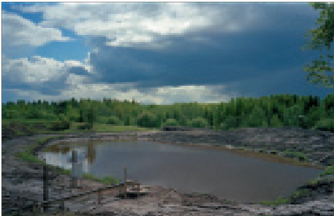
Kuva 4. Tyrväen koealueen varastoallas valumavesien kierrätystä varten kesäkuussa 1994. Allas rakennettiin syksyllä 1993. Vasemmassa alakulmassa pellolle nouseva kasteluvesiputki.
