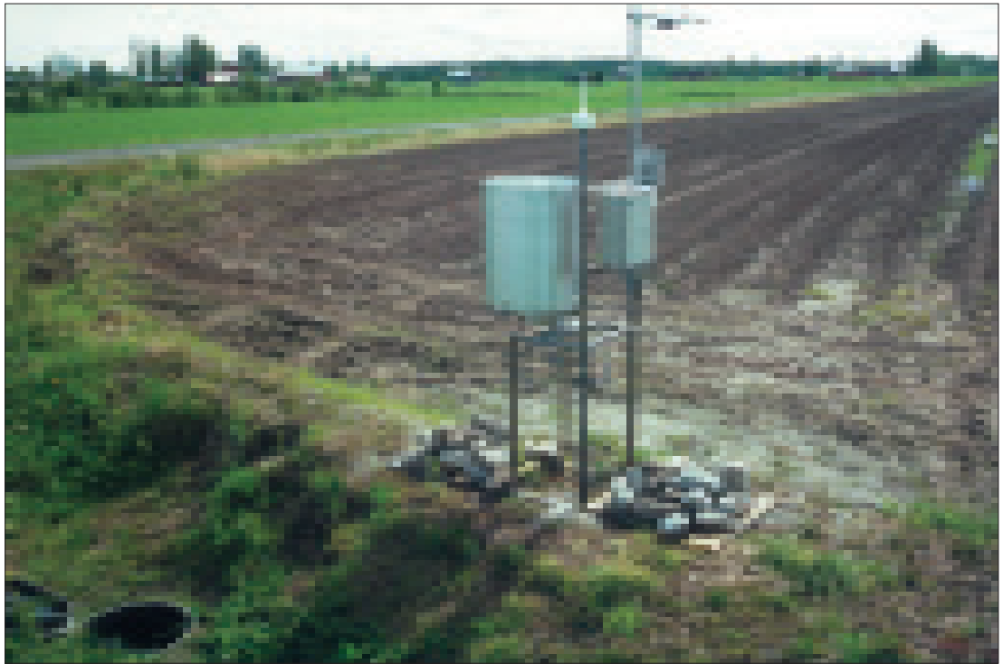
Kuva 2. Sääasema ja tiedonkeruuyksikkö Lapuan koealueella toukokuussa 1994. Etualalla säätö- kaivo ja taustalla pohjavesiputkia. Säätkökaivon korkeutta lisättiin 30 cm kesäkuussa 1995.
