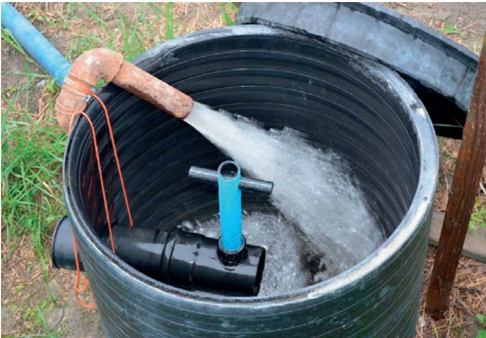
Salaajakastelua, jossa vesi johdetaan säätökaivon kautta salaojastoon.
