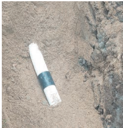
Liitosholkilla tehty putkiliitos. (alla)
