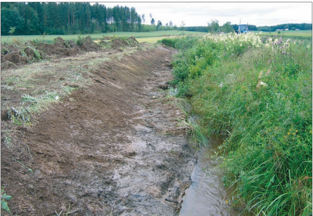
Kuva 6.25 Tulvatasanne voidaan tehdä vain toiselle puolelle uomaa ja toisen puolen kasvillisuus jätetään koskemattomaksi (Kuva Liisa Laitinen).
