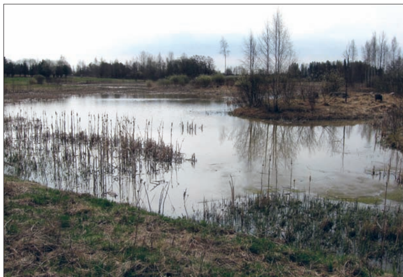
Kuva 6.30 Mäyränojan laskeutusallas yläjuoksulle päin toukokuussa 2009 seitsemän vuotta rakentamisen jälkeen. (Kuva Juha Järvelä)
