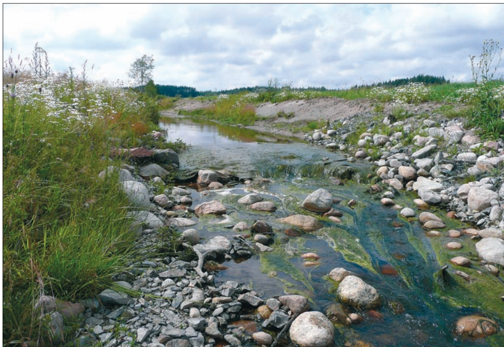
Kuva 6.26 Juottimenojaan rakennettu pohjakynnys. Kynnys hidastaa virtausta ja pidättää kiintoainesta (Kuva Maija Paasonen-Kivekäs).
