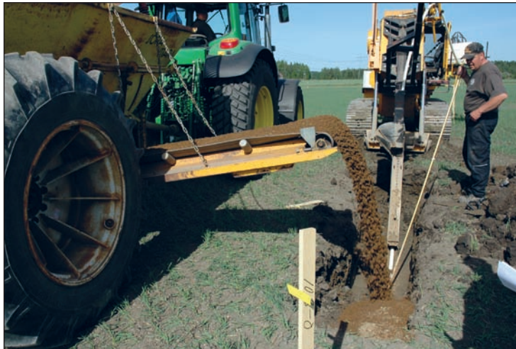
Kuva 7.40 Salaojitusta kaivavalla salaojakoneella ympärysaineena sora. (Kuva Helena Äijö)
