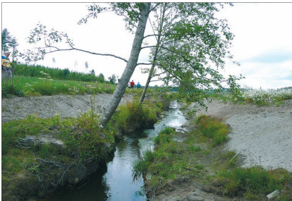
Kuva 6.27 Kunnostettua Juottimenojaa. Uoman varteen on jätetty puita ja muuta kasvillisuutta sitomaan maata eroosiota vastaan sekä monipuolistamaan maisemaa ja antamaan eliöille suojaa ja ravintoa (Kuva Maija Paasonen-Kivekäs).
