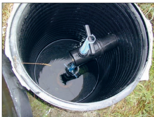
Kuva 8.3 Salaojaston kokoojaputken laskuaukossa sijaitseva säätökaivo ja sen vaikutuspiirissä oleva 2,5 hehtaarin peltoalue. (Kuvat Maija Paasonen-Kivekäs ja Rainer Rosendahl)
