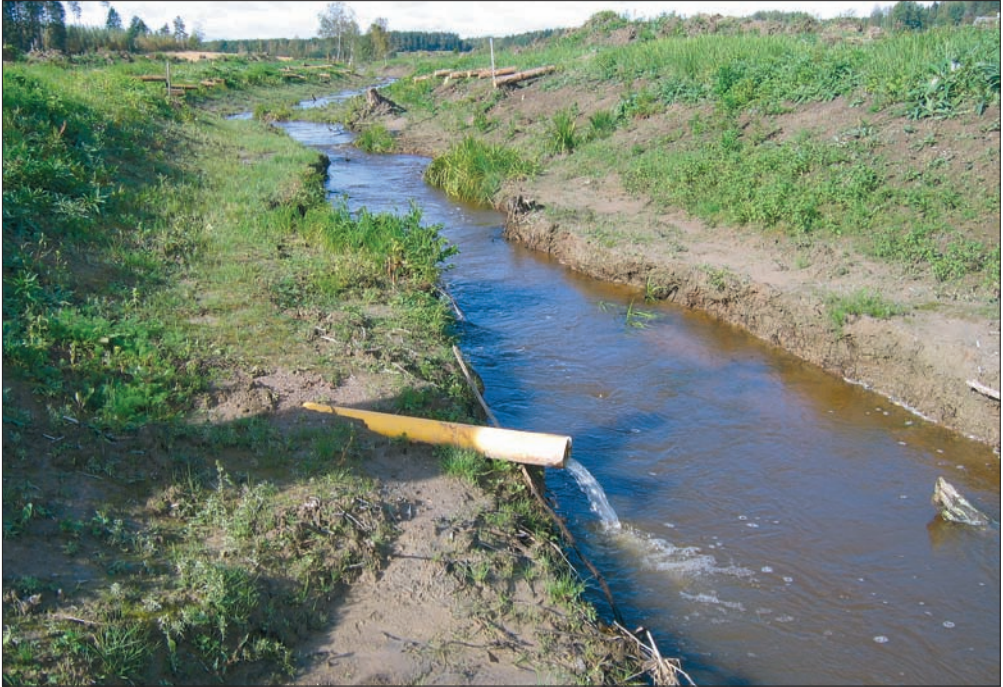
Kuva 6.24 Perniön Juottimenojaa kunnostuksen jälkeen. Mutkittelleen alivesiuoman yläpuolelle on kaivettu tulvatasanteet uoman vedenjohtokyvyn parantamiseksi (Kuva Liisa Laitinen).
