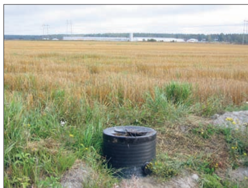
Kuva 8.3 Salaojaston kokoojaputken laskuaukossa sijaitseva säätökaivo ja sen vaikutuspiirissä oleva 2,5 hehtaarin peltoalue. (Kuvat Maija Paasonen-Kivekäs ja Rainer Rosendahl)
