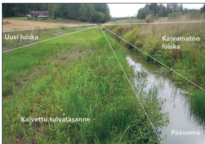
Kuva 5.19. Ritobäckenin koekohteen kaksitasouomassa keskivedenkorkeutta suuremmat virtaamat pääsevät nousemaan toispuoleisesti kaivetulle tulvatasanteelle, joka parantaa tulvanjohtokykyä ja kiintoaineen pidättymistä (Kuva Kaisa Västilä).
