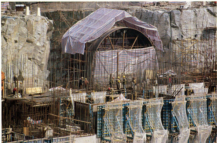
Kuva 1. Kiinan luonnonvarat käyvät niukiksi. Vesivarojen hyödyntämistä tehostetaan massiivisesti. Esimerkiksi Yangtzen valuma-alueella on jo 46 627 tekojärveä (Chen & Yongqiang 1999), ja suurin, kolmen kanjonin patojärvi, lisää niiden varastotilavuutta kuudenneksen. Hankkeiden massiivisuus herättää runsaasti kysymyksiä ja kritiikkiä. Alkaako suurten ja mahtavien monumenttien aika olla Kiinassakin ohi? Kuvassa kolmen kanjonin padon rakennustyömaa marraskuussa 1999.
