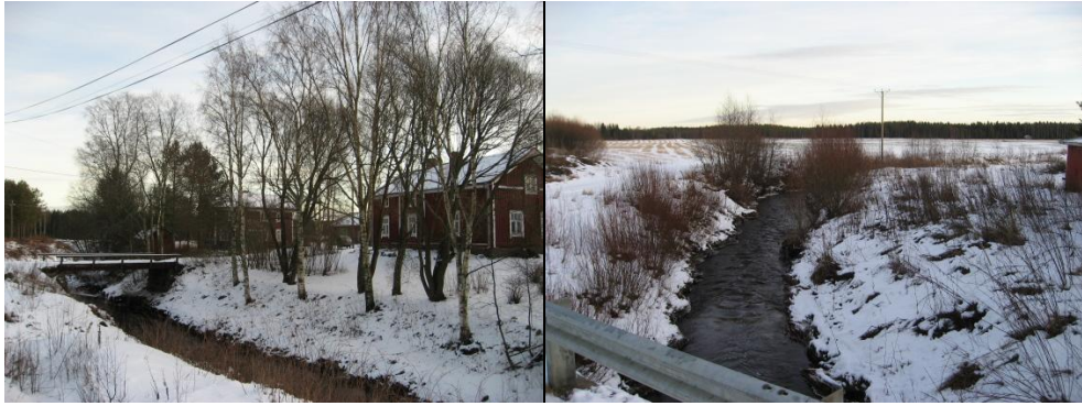
Kuva 7. Vasemmalla Vakkurin silta, oikealla Ekoluoman valuma-alue Huhtamäen sillalta alajuoksulle kuvattuna. Kuvattu 26.12.2008.
