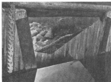
Kuva 20. Myllykorvenojan mittapato yläpuolelta katsottuna ja vesiasteikko. (Kaitera 1939a)
