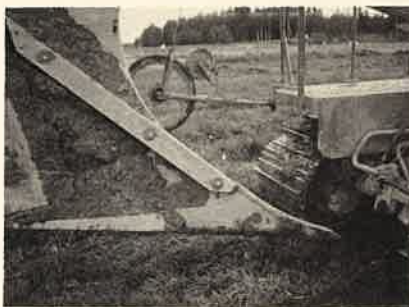
Kuva 1. Aura, jolla putkelle tehdään tila maahan.
