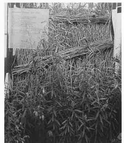
Kuva 7. Tavoitteena on joen vapaa virtaus. Tarvittaessa rantoja voidaan vahvistaa ns. insinööribiologisin menetelmin kuten pajukatteella ja -rusungilla.
