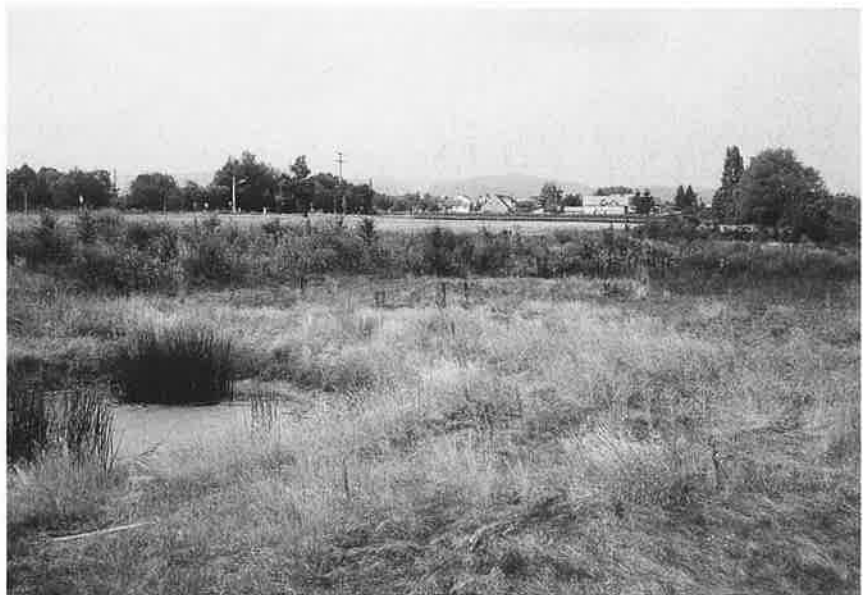
Kuva 9. Sadevedenpidätysaltaat tasoittavat ylivirtaamia ja luovat samalla monipuolisia kos- teikkobiotooppeja.
