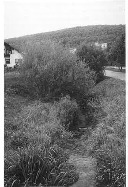
Kuva 12. Gutenbach-puron linjausta siirrettiin asuntorakentamisen takia ja samalla trapsiprofiilinen uoma luonnonmukaistettiin.
