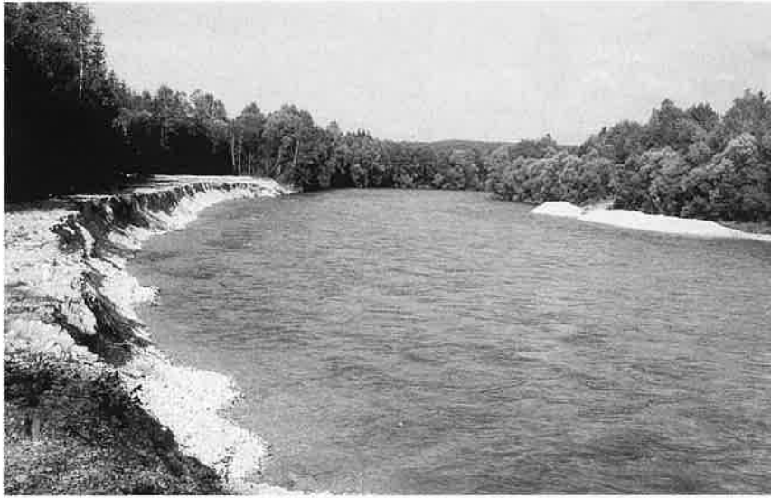
Kuva 10. Isar-jokea luonnonmukaistetaan poistamalla eroosiosuojauksia ja antamalla virtauksen muotoilla uomaa. Oikealla jokea syötetään soralla aiemman pohjaerosion korvaamiseksi.
