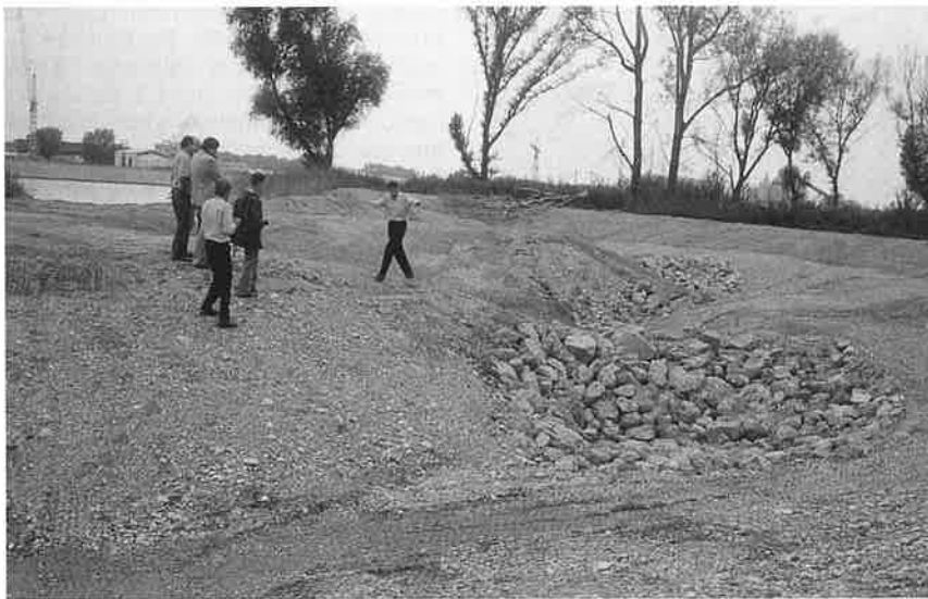
Kuva 13. Wienissä Freudenaun rakenteilla olevan vesivoimalan viereen luodaan 1,5 km pitkä puomainen kalatie – taustalla voimalan tulokanava.
