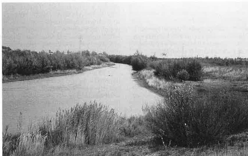
Kuva 14. Marchfeld-kanavan rakentamisessa on luotu loivia ja vaihtelevia penkereitä, mikä tarjoaa elintilaa vyöhykkeiselle kasvillisuudelle ja eliöstölle.
