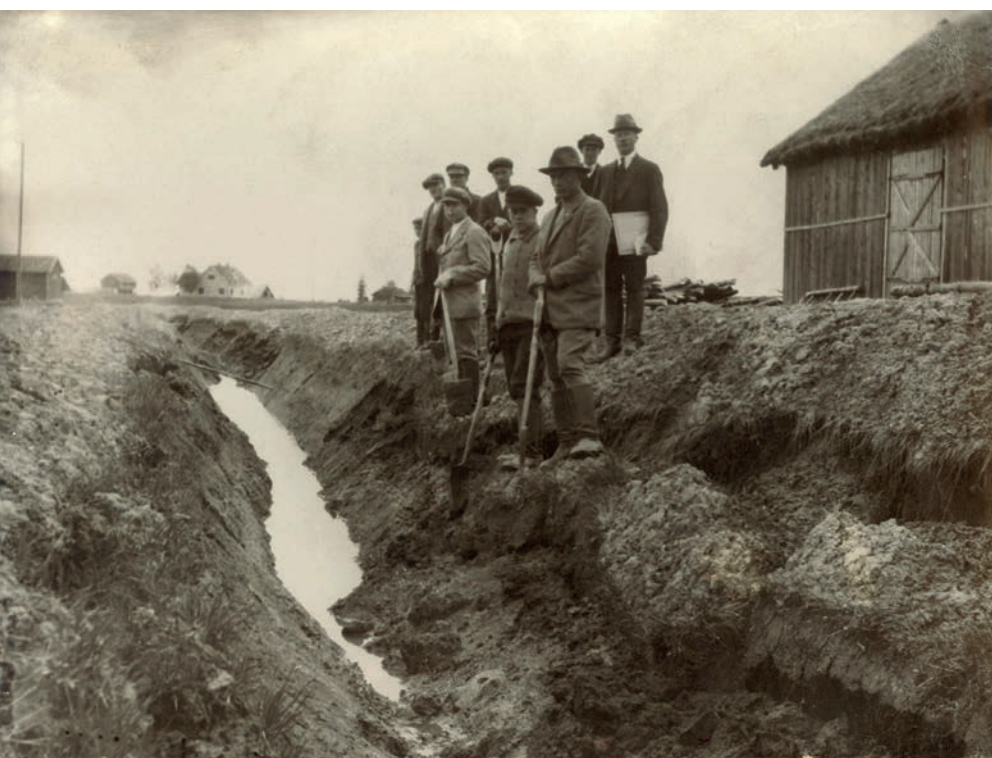
Kuva 2. Valtaojatyömaa 1920-luvulla (vasen) ja salaojan kaivua 1930-luvulla (yllä). (Kuvat Salaojayhdistys)
