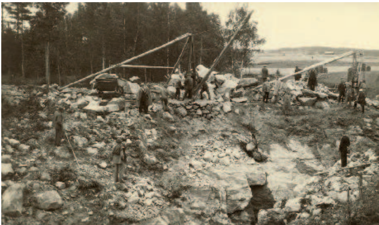
Kuva 4. Valtaojan kaivua 1950-luvulla. (Kuva Salaojayhdistys)
