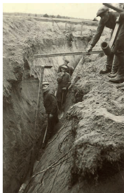
Kuva 2. Valtaojatyömaa 1920-luvulla (vasen) ja salaojan kaivua 1930-luvulla (yllä). (Kuvat Salaojayhdistys)
