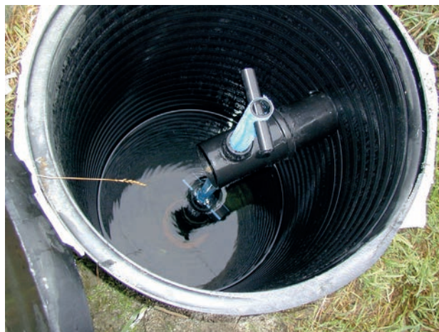
Kuva 8. Säätösalaajitusta ja altakastelua, jossa kastelu hoidetaan pumpaamalla vettä avo-ojaan Närpiössä, Rangsbyn kylässä (vasen), ja säättökaivo salaajaston kookojaputkessa (yllä). (Kuvat Rainer Rosendahl)
