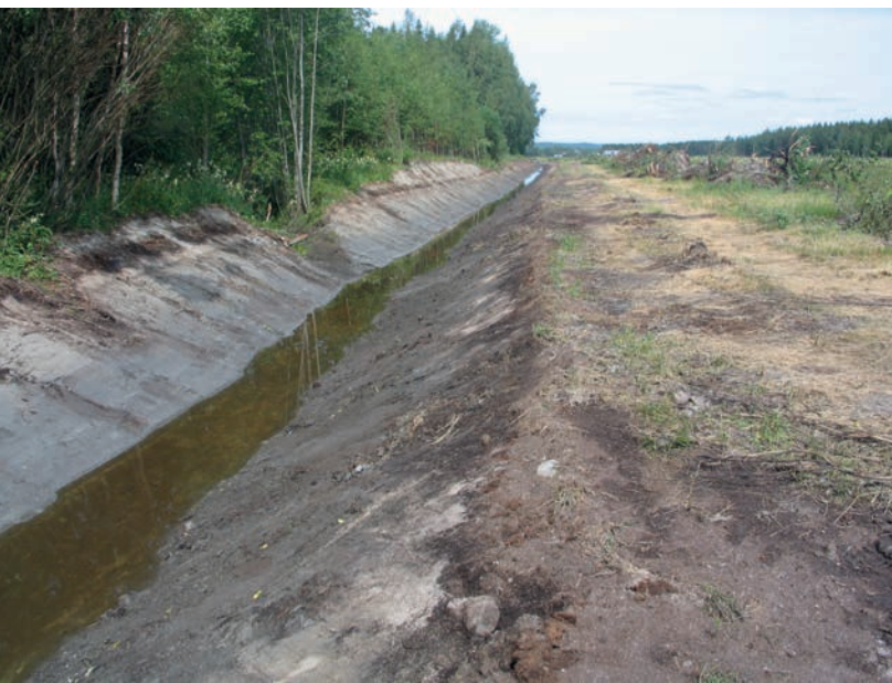
Kuva 7. Vanhan valtaojan perkausta (luiskat 1:2) Dagsmarkissa Etelä-Pohjanmaalla (vasen) ja luonnonmukaisen vesirakentamisen mukaisesti kunnostettua peruskuivatusuomaa Juottimenojalla Perniössä (oikea). (Kuvat Rainer Rosendahl ja Maija Paasonen-Kivekäs)
