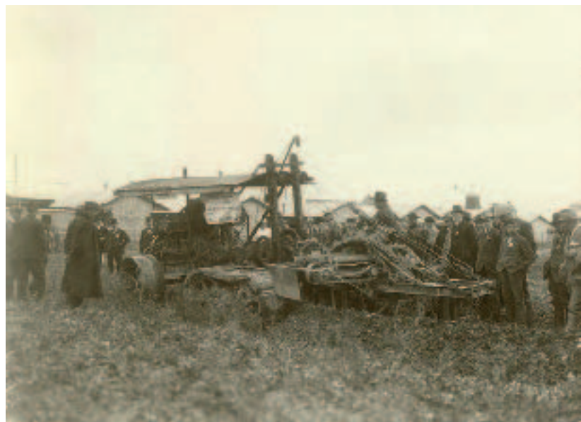
Kuva 3. Hevosvetoinen oja-aura (vasen) ja salaojakaivukone 1920-luvulla (oikea). (Kuvat Salaojayhdistys)
