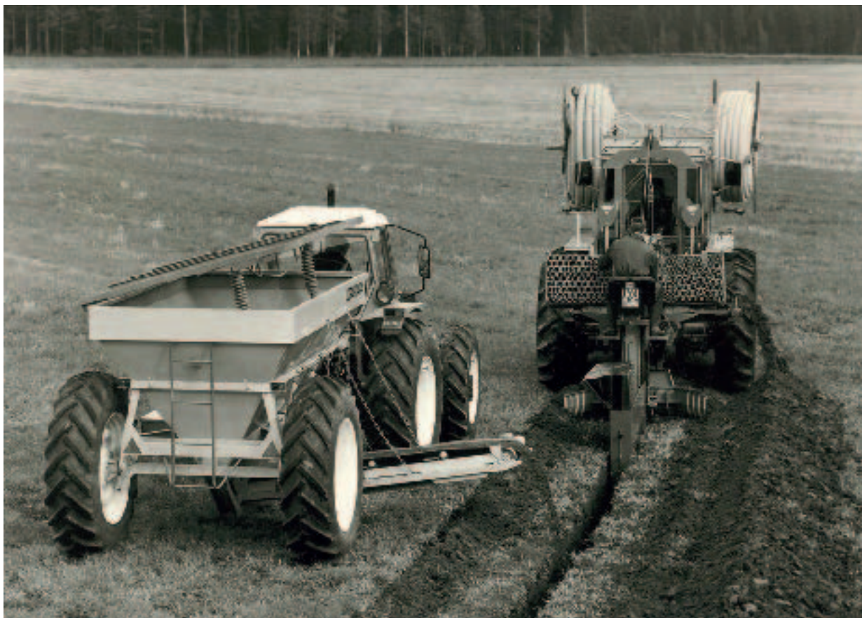
Kuva 6. Saloajitustyömaa 1980-luvulla. (Kuva Salaojayhdistys)
