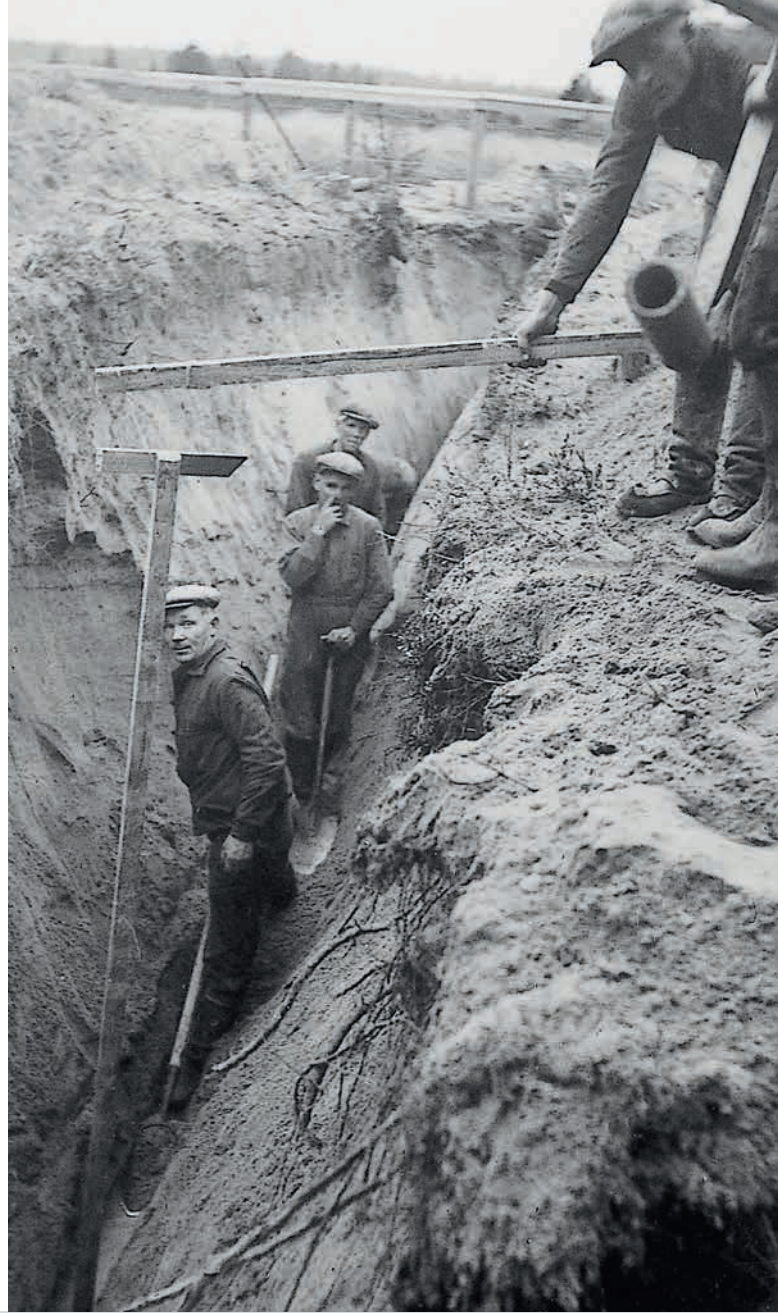
Salaojan kaivua 1930-luvulla.
